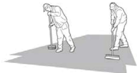
**01** Antes de colocar, deve-se deixar aclimatizar as placas por 24 horas, nivelar e varrer o chão.
